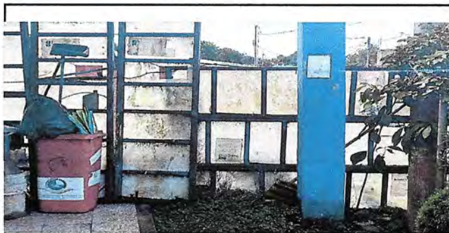
Foto 5: cerco o muro perimetral
