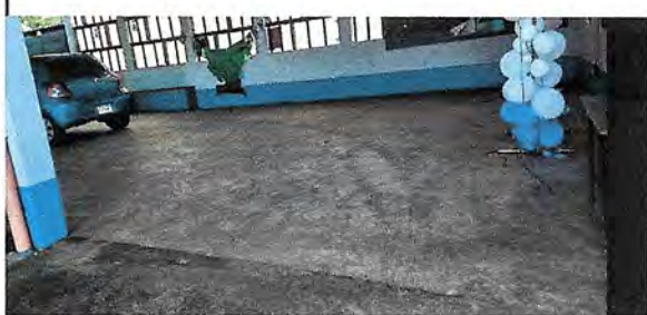
Foto1: sustitución de piso, salón
