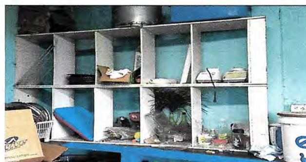
Foto 2: reparación o sustitución en el área de cocina por gabinete aereo
