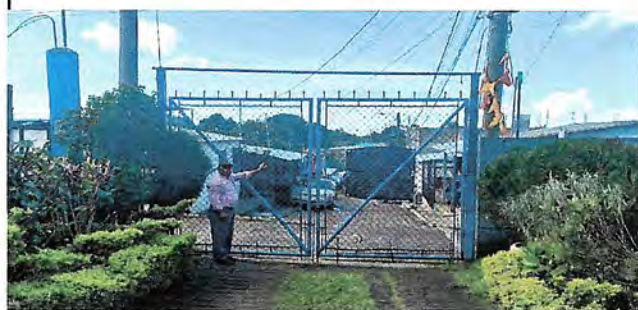
Foto 6: mantenimiento de portón
