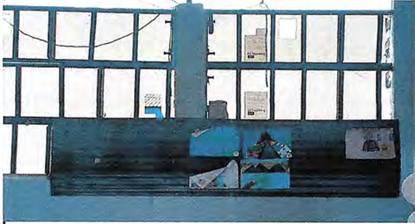
Foto 3: sellado de vanos de ventanas por levantado de block
