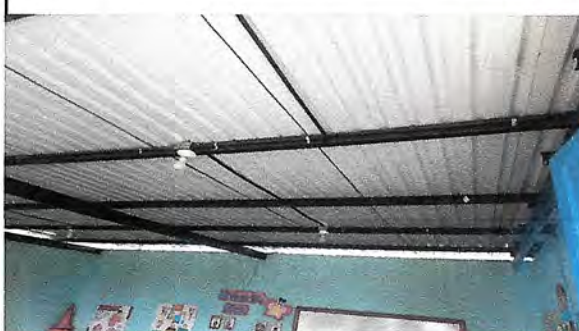
Foto 6: estructura de techo aula quinto y sexto
