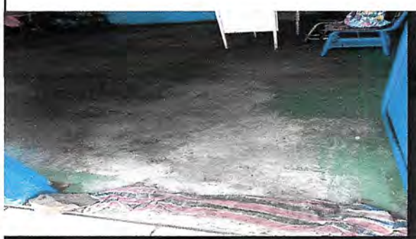
Foto 2: sustitución de piso, aula quinto y sexto
