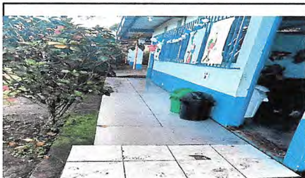
Foto 3: sustitución de piso, pasillo quinto y sexto
