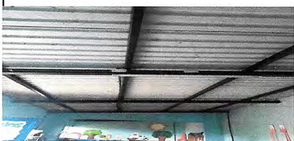
Foto 5: estructura de techo pàrvulos
