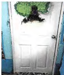
Foto 4: sustitución de puertas aula cuarto
