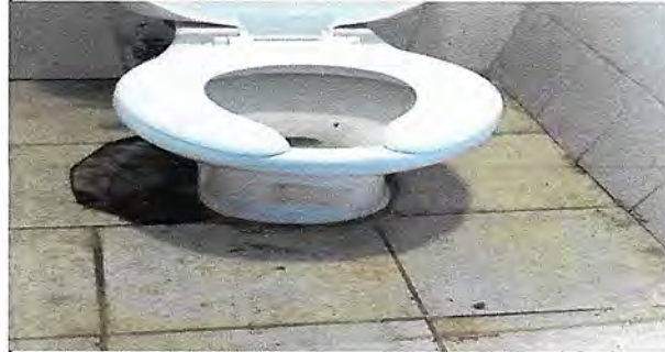
Foto 4: Sustitución de baño y cambio de accesorios y piso
