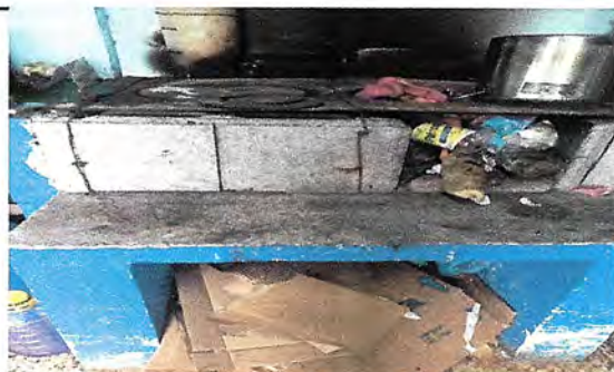
Foto 3: sustitución de plancha artesanal
