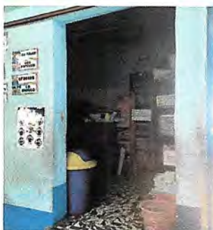
Foto 5: sustitución de puertas bodega
