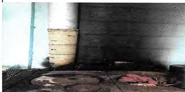
Foto 1: sustitución de chimenea
