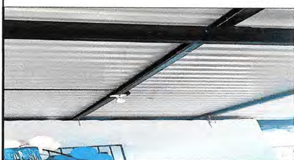
Foto 1: Reparación de sistema eléctrico
