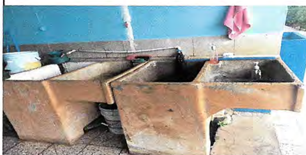
Foto 4: sustitución de pilas del lavadero y dos lavaderos
