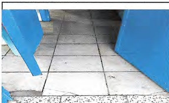
Foto 4: sustitución de piso, baños
