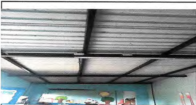
Foto 3: Reparación de sistema eléctrico párvulos
