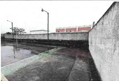
Foto 1: Pintura de muros exterior. Pintura de muro perimetral y gradas.
