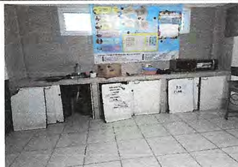
Foto 10: Sustitución de área de cocina. Sustitución de puertas de gabinetes por puertas de metal.
