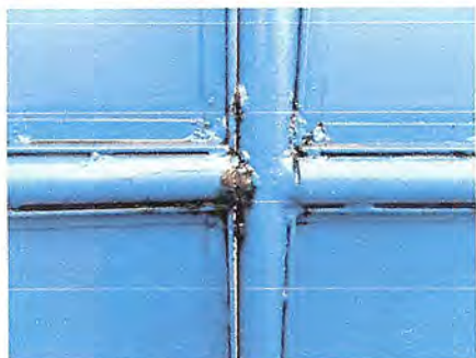
Foto7: Mantenimiento a portones. Remozamiento de áreas que se encuentran quebradas.
