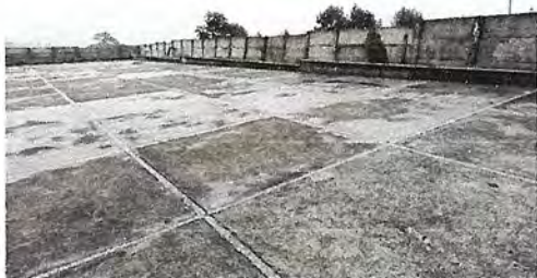
Foto 3: Pintura de muros interior. Pintura de muro perimetral y banqueta.
