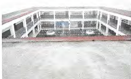
Foto 11: Impermeabilización de losa. Aplicación de impermeabilizante en toda la losa.
