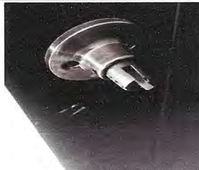
Foto 2: Puertas. Cambio de chapas en puertas.
