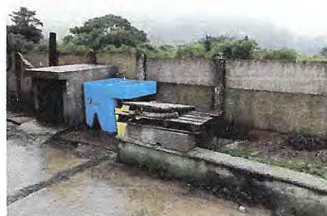
Foto 4: Sustitución de pila y estructura de techo.
