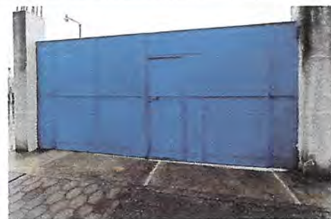
Foto 6: Mantenimiento a portones.
