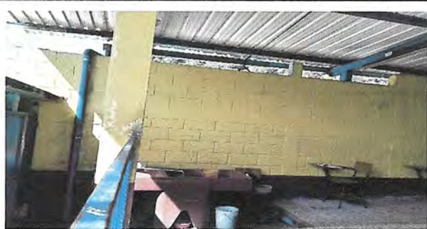
Foto 1: AMPLIACION DE SANITARIOS
