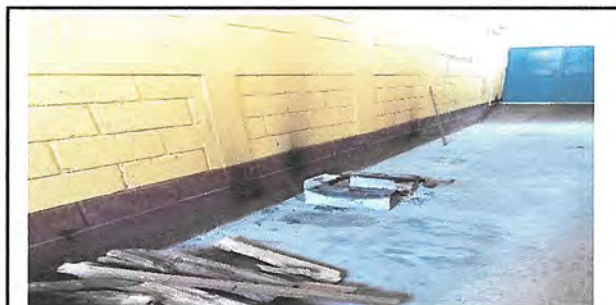
Foto 3: INSTALACION DE UN POLLETON DE CONCRETO
