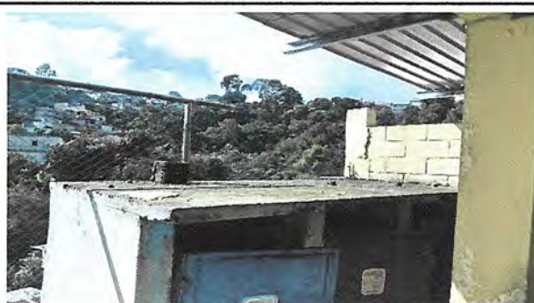
Foto 4: COMPRA E INSTALACION DE TINACOS
