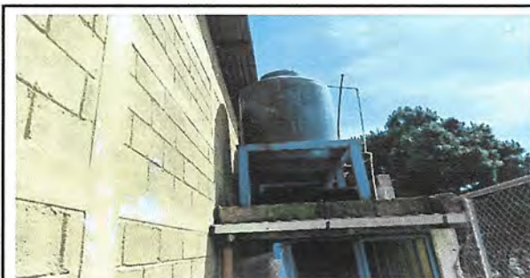
Foto 4: PINTURA DE BASE DE TINACO Y CAMBIO DE TINACO PERFORADO
