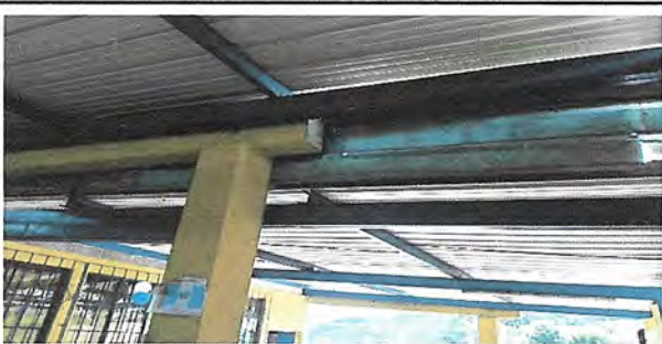
Foto 3: CAMBIO DE LAMINA EN CORREDOR
