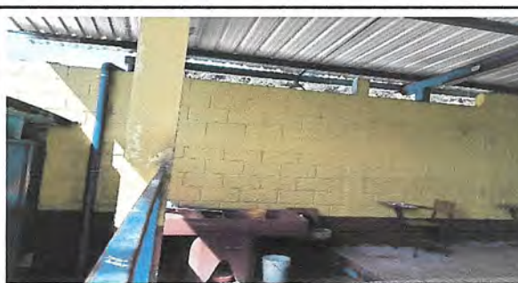
Foto 6: INSTALACION DE UN LAVAMANOS CORRIDO
