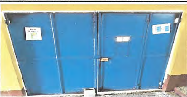
Foto 5: CAMBIO DE PORTON DE INGRESO
