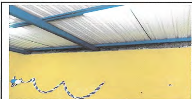
Foto 5: INSTALACION DE FLANCH POR FILTRACION
