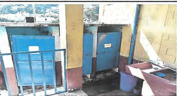
Foto 6: AMPLIACION DE SANITARIO CON MIGITORIO
