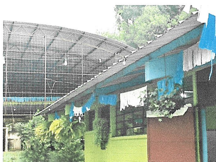
Foto 1: Instalación de canal y bajadas pluviales.
