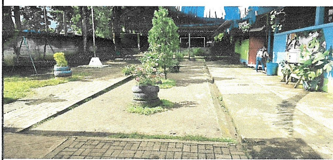
Foto 3: Fundición de losa de patio de concreto.
