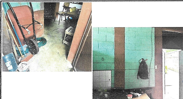
Foto 2: Instalación de piso y remozamiento de muro en bodega y guardiania.
