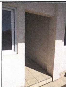
Foto 3: Fabricación e instalacion de puertas y balcones para protección de ventanas de pvc.
