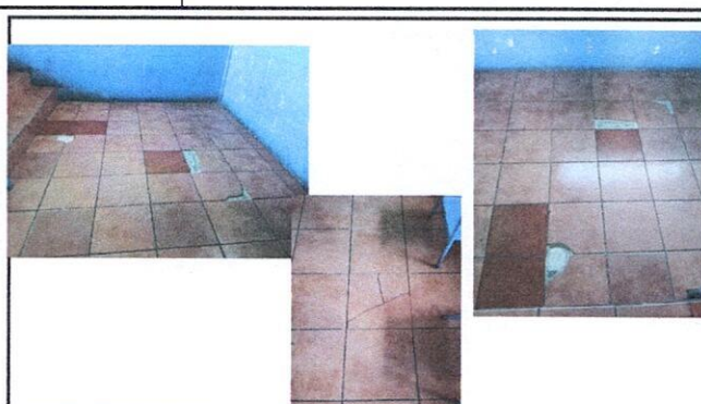
Foto 2: sustitucion de piso en area de aulas gradas y pasillos con piso color rojo mate
