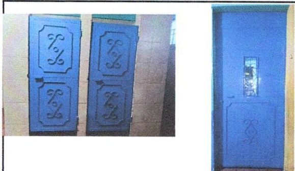
Foto1: colocacion de chapas en puertas y modificacion de puerta de direccion y mantenimiento de puertas en sanitarios de niños y niñas
