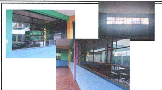
Foto1: Cambio de vidrios en diferentes areas del establecimiento aulas , cocina y ventanas interiores ,
