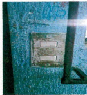
Foto 2: 17.7 Sustitución de interruptores dobles; por antigüedad
