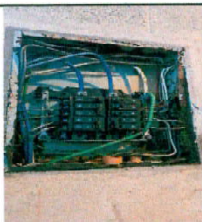
Foto 5: 4.10 Sustitución de tablero de flipones; por antigüedad y mal estado
