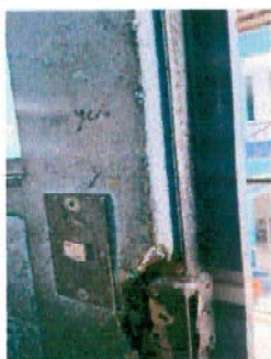
Foto 1: 17.6 Sustitución de interruptores simples; por antigüedad y algunos ya estan todos flojos
