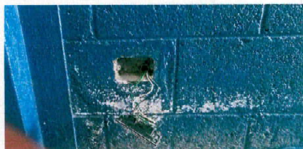
Foto 6: Reparación de cableado electrico en el primer nivel y tercero del modulo 1 por antigüedad y se queman mucho las bombillas
