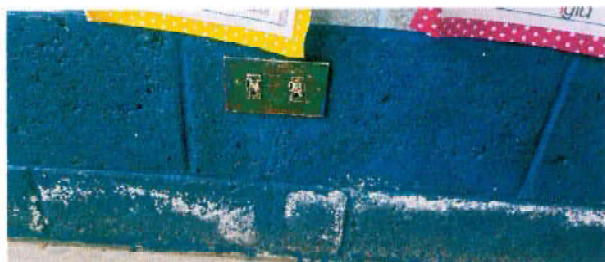
Foto 3: 17.8 Sustitución de tomacorrientes dobles; por antigüedad
