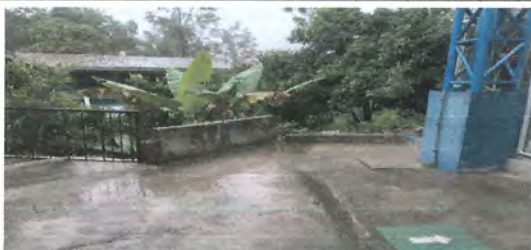
Foto 5: Instalación de baranda.
