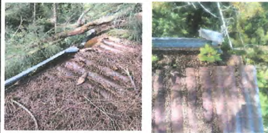
Foto 4: Sustrucción de canales dañados.
