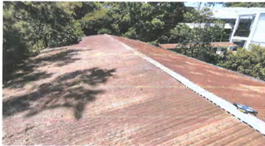
Foto 1: Sustrucción de lámina tercer nivel.
