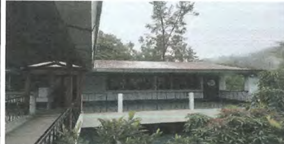
Foto 2: Sustrucción de lámina en aulas tercer nivel.
