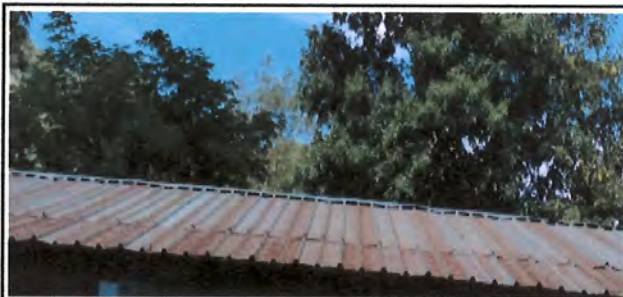
Foto 3: Sustitución de laminado por lamina troquelada calibre 26 en el patio de la escuela direccion.
