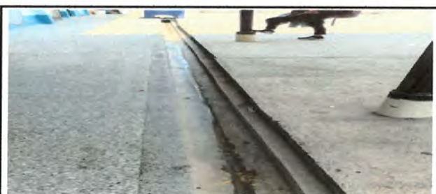
Foto 5: Instalacion de Rejilla en area de patio sobre cuneta
