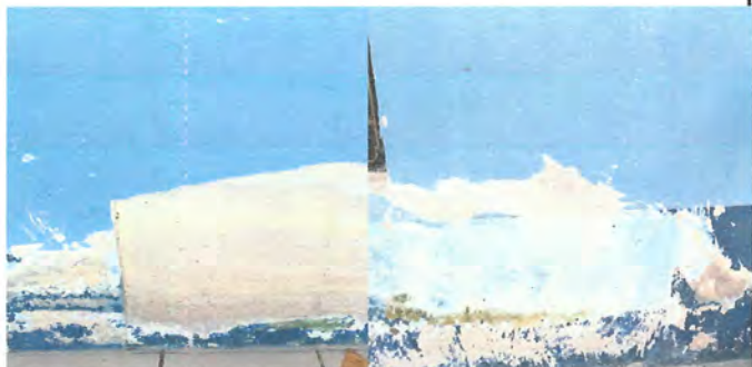
Foto 1: APLICACIÓN DE REPELLO Y CERNIDO EN MURO
