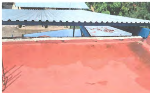
Foto 4: REPARACIÓN DE MURO EN TERCER NIVEL
