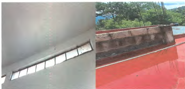
Foto 11: SUSTITUCIÓN DE VENTANA POR BLOCK DE VIDRIO EN TERCER NIVEL
