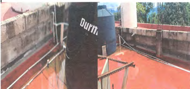
Foto 9 : SUSTITUCIÓN DE TUBERIA DE 1/2", INCLUYE DE KIT DE LLAVES DE TINACOS
