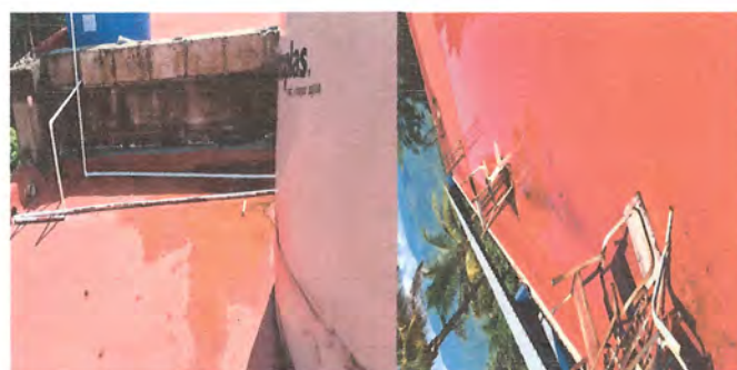
Foto 6: REMOCION DE PAÑUELO EN MAL ESTADO, SUSTITUCION DE PAÑUELO E IMPERMEABILIZANTA DE LOSA. SUMINISTRO E INSTALACION DE BAJADA DE AGUA PLUVIAL
