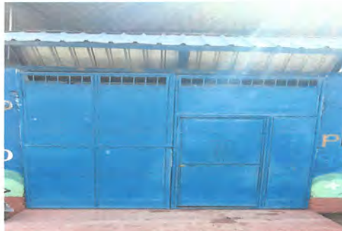
Foto 2: MANTENIMIENTO Y MODIFICACION DE PORTON A CORREDIZO A ESTRUCTURA (LIJADO, SUJECCIONES, APLICACION DE PINTURA) SUSTITUCION DE CHAPA YALE. MANTENIMIENTO DE ESTRUCTURA DE
