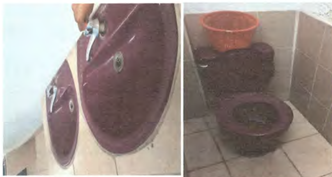
Foto 7: SUSTITUCION DE JUEGOS DE ACCESORIOS PARA BAÑOS. SUSTITUCIÓN DE GRIFOS EN BAÑOS
