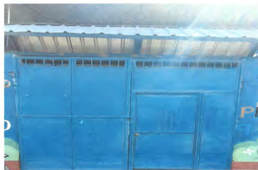
Foto 10: MANTENIMIENTO DE ESTRUCTURA DE METAL DE TECHADO DE PORTON DE ACCESO
