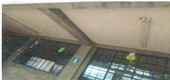
Foto 5: Sustitución de lámparas de 2 x 40 por foco tipo led incluye instalación de plafonera en el primer nivel
