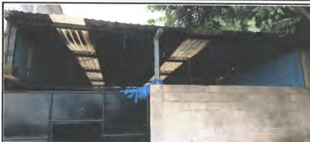
Foto 8: 6. Instalacion de canal. Pintura de interior y exterior.
