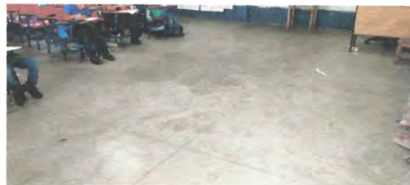
Foto 2: 6. Instalación de piso cerámico en aulas
