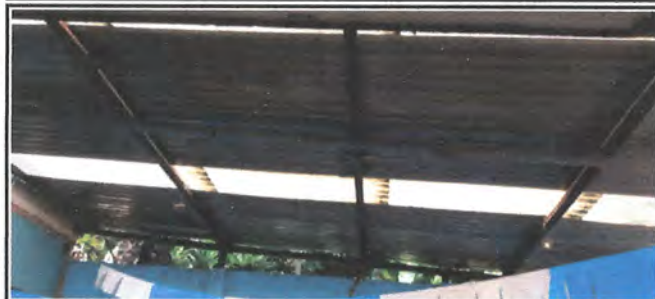
Foto 5: 1. Cubierta de lamina. 1.1 Sustitución de lamina en la cancha.
