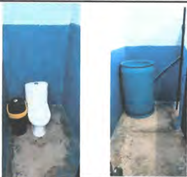
Foto 7: 6. Instalación de piso ceramico y azulejo en baños
