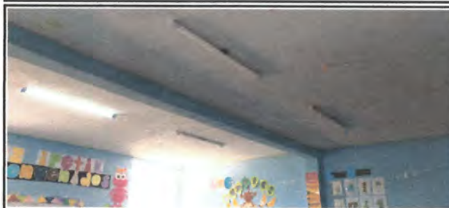
Foto 6: 17. Reparación de sistema eléctrico. 17.4 Sustitución de focos ahorradores. 17.5 Sustitución de plafoneras. 17.11 Reparación de cableado eléctrico. En aulas.
