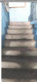
Foto 3: Instalación de piso cerámico en gradas
