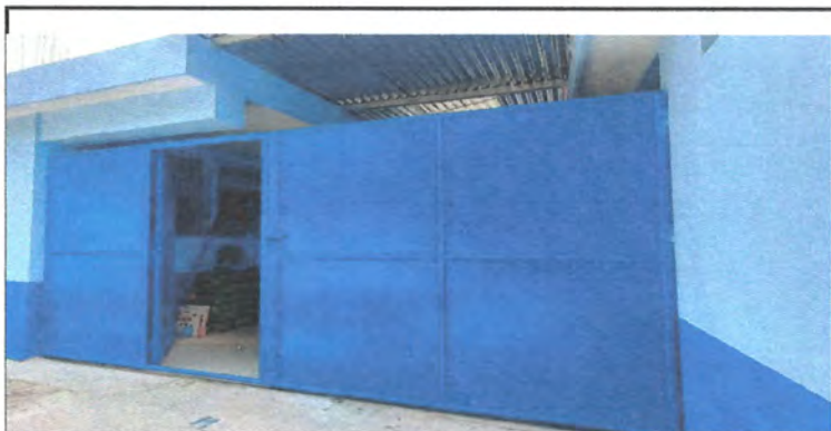
Foto 14: SUMINISTRO E INSTALACION DE MARCO CON MALLA SOBRE EL PORTON DE 2.15 X 0.65 M
