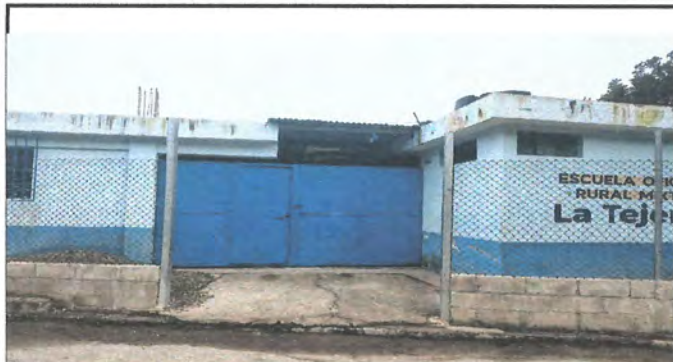
Foto1: INSTALACION DE CUBIERTA DE LAMINA EN LA ENTRADA DE LA ESCUELA EN AREA DE PORTON
