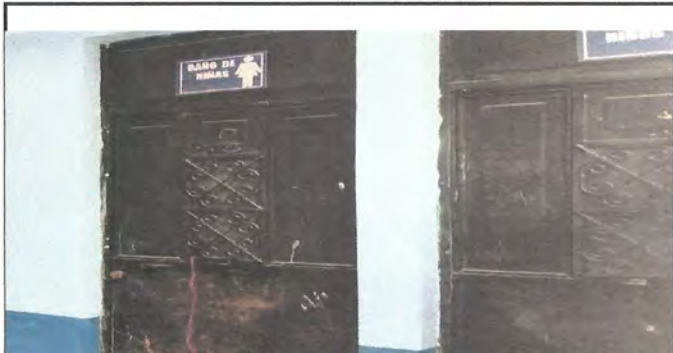
Foto 4: SUSTITUCION DE PUERTAS DE METAL EN BAÑOS
