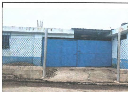
Foto 14: SUMINISTRO E INSTALACION DE PORTON CORRED
