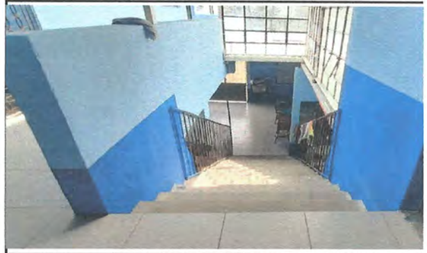
Foto 8: INSTALACION DE PISO ANTIDESLISANTE EN AREAS DE GRADAS
