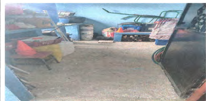
Foto 5: SUSTITUCION DE PISO DE TORTA DE CONCRETO POR PISO CERAMICO EN AREA DE COCINA
