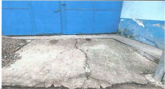
Foto 7: SUSTITUCION DE PISO DE TORTA DE CONCRETO POR PISO DE PATIO DE UN ESPESOR DE 10CM
