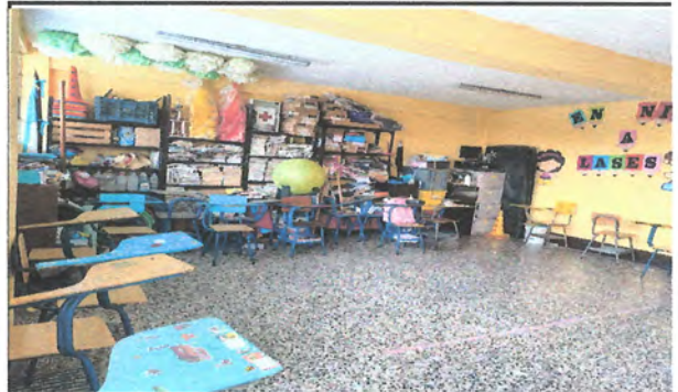
Foto 10: PINTURA EN MUROS EXTERIORES E INTERIORES DE AULAS
