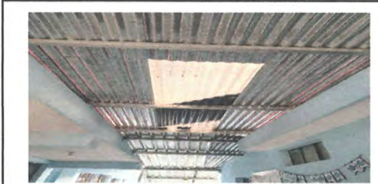
Foto 20: INSTALACION DE PLAFONERAS EN EL AREA DE MARQUESINA
