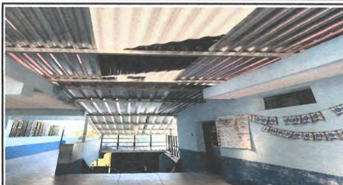
Foto 2: SUSTITUCION DE LAMINA TROQUELADA ALUZINC CALIBRE 26 EN EL AREA DE CORREDOR
