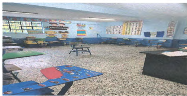
Foto 9: SUSTITUCION DE PISO DE GRANITO POR TORTA DE CONCRETO DE 10 CM MAS INSTALACION DE PISO CERAMICO
