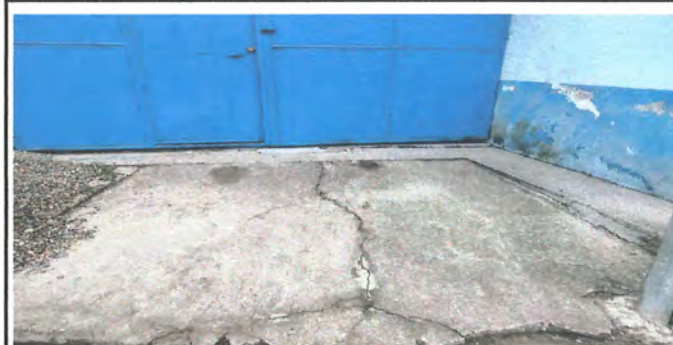
Foto 6: SUSTITUCION DE PISO DE TORTA DE CONCRETO POR PISO ANTIDESLISANTE
