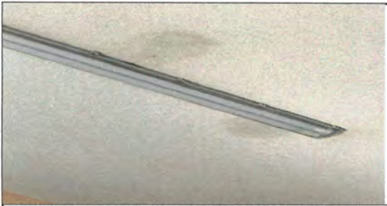
Foto 18: SUSTITUCION DE LAMPARA TIPO TUBO LED POR PLAFONERAS DECORATIVA CON FOCO LED REDONDO INCLUIDO
