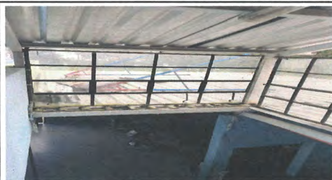
Foto 3: SUMINISTRO E INSTALACION DE CAPOTES EN LA ORILLA DEL AULA DEL SOTANO
