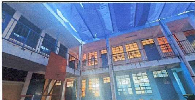
Foto 3: Sustrucción del ducto electrico
