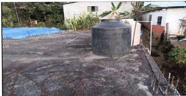
Foto 6: Sustrucción de deposito de agua
