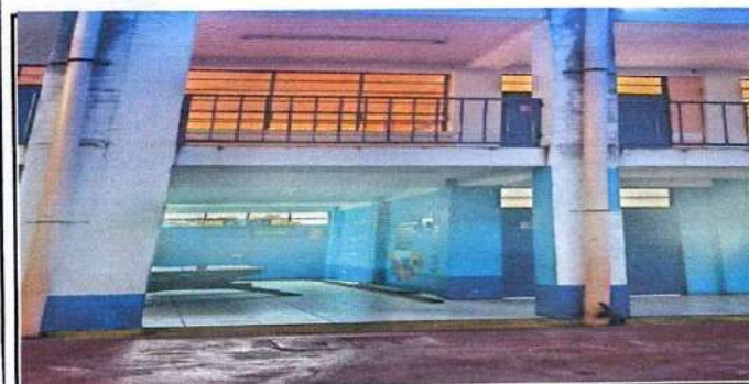
Foto 5: Sustrucción de bajadas de agua pluvial
