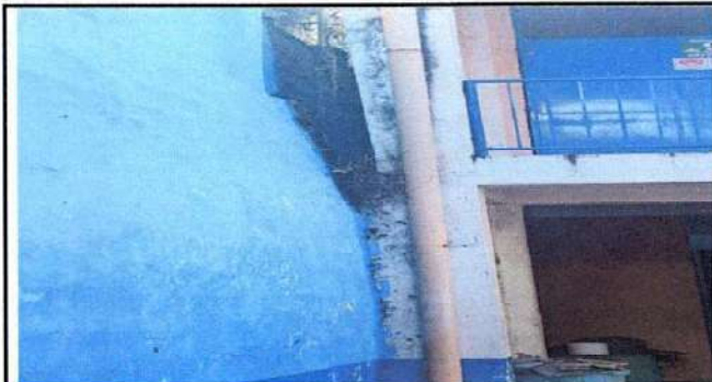
Foto 4: sustitucion de tubos
