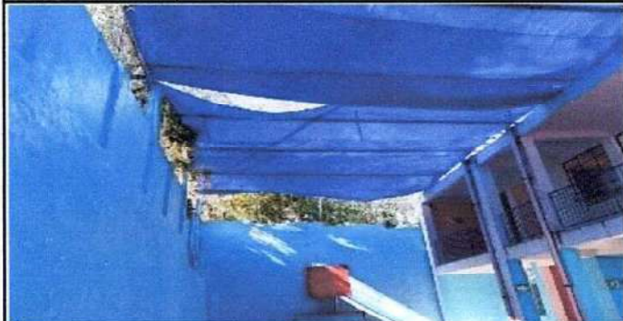
Foto 1: Sustrucción de Estructura de soporte de metal
