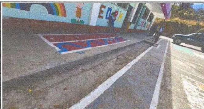
Foto 8: Imagen donde se observa el estado actual del área donde se realizará la reparación de cuneta
