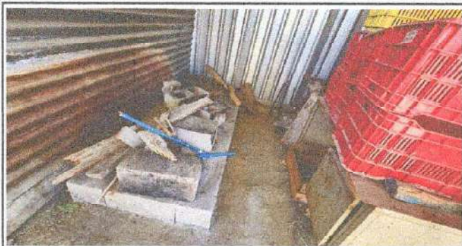
Foto 7: Imagen donde se observa el estado actual del poilo de leña del centro educativo
