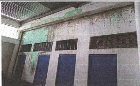
Foto1: Repello de muro
