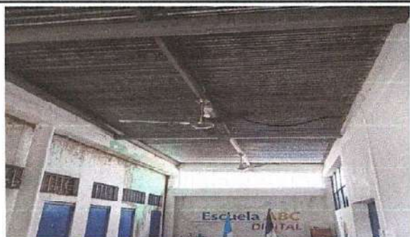
Foto 3: Instalación de cielo falso y cobertura de columnas con tabla yeso
