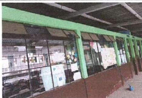
Foto 5: Sustitución de ventana de metal
