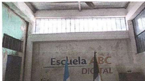
Foto 6: fabricación e instalación de ventana pvc
