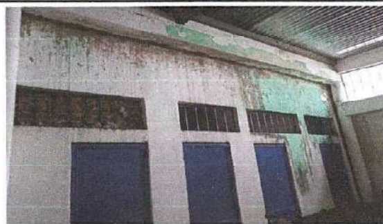
Foto 4: Reparación de muros
