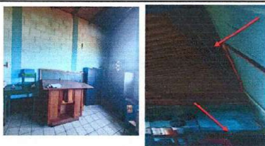
Foto 6: reparación de azulejo de mueble de cocina / sustitución de tubería principal (cocina)
