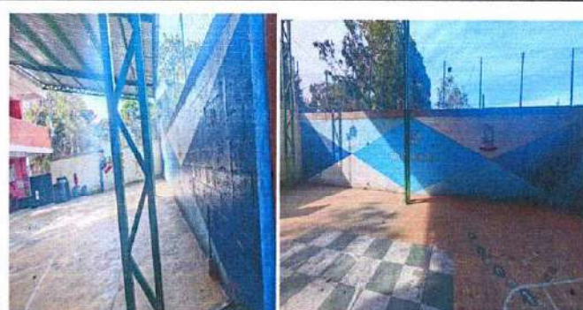
Foto 2: Reparación del muro perimetral
