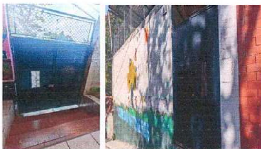
Foto 3: Mantenimiento a estructura
