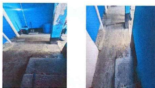
Foto 4: Sustitución de torta por piso Granito (Área baños)
