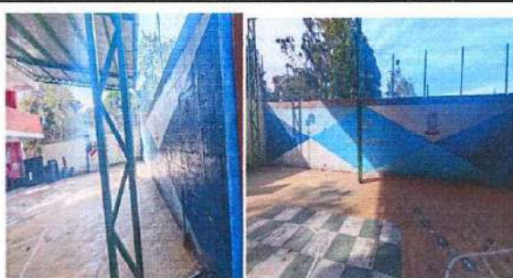
Foto 2: Reparación del muro perimetral
