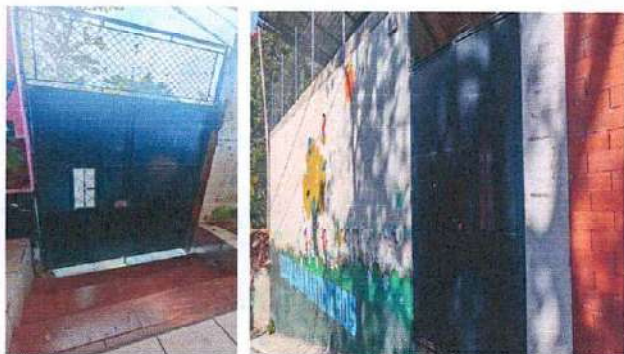
Foto 3: Mantenimiento a estructura
