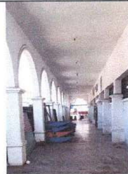
Foto 2: Pintura en el corredor de afuera
