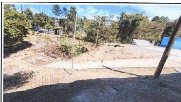
Foto 12: Imagen donde se observa el estado actual del muro perimetral existente.
