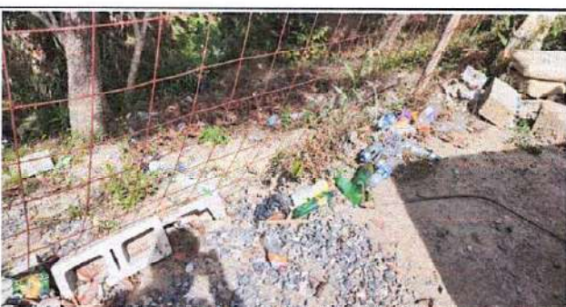
Foto 6: Imagen donde se observa el estado actual del muro perimetral existente.
