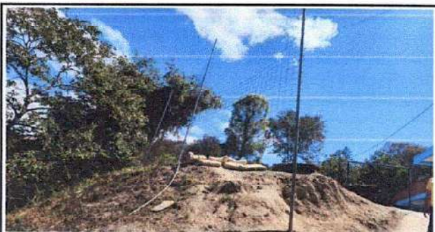
Foto 3: Imagen donde se observa el estado actual del muro perimetral existente.
