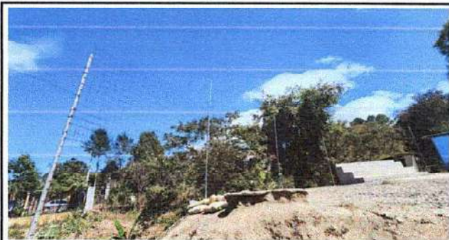
Foto 1: Imagen donde se observa el estado actual del muro perimetral existente.
