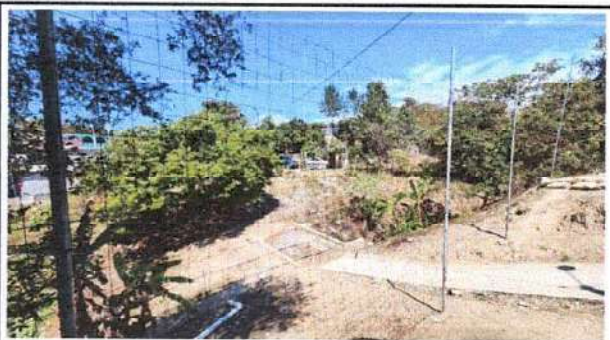
Foto 9: Imagen donde se observa el estado actual del muro perimetral existente.
