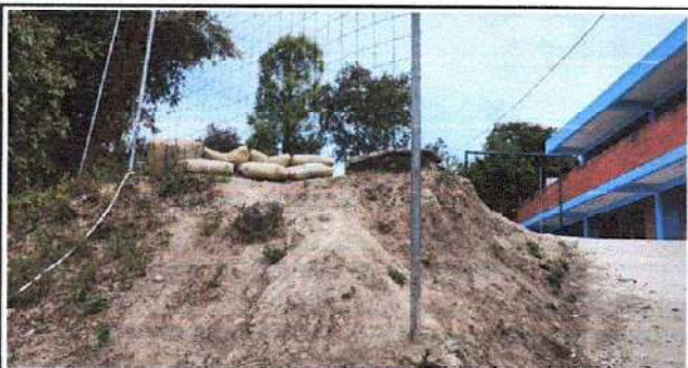
Foto 5: Imagen donde se observa el estado actual del muro perimetral existente.
