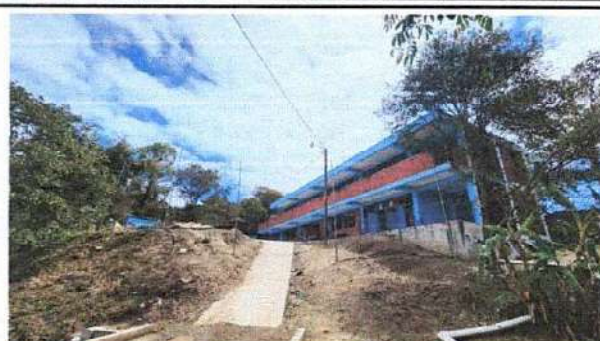
Foto 8: Imagen donde se observa el estado actual del muro perimetral existente.
