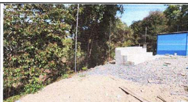
Foto 4: Imagen donde se observa el estado actual del muro perimetral existente.
