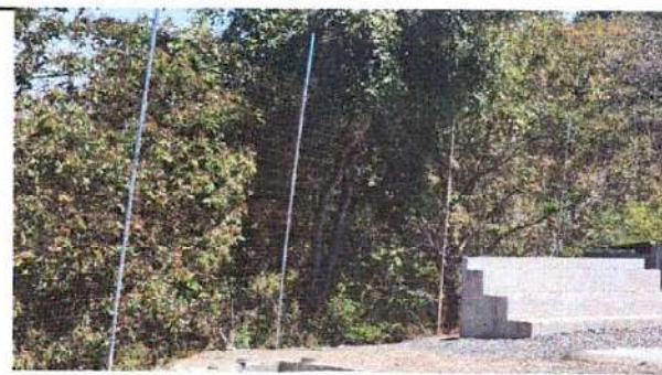
Foto 10: Imagen donde se observa el estado actual del muro perimetral existente.
