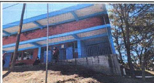
Foto 2: Imagen donde se observa el estado actual del muro perimetral existente.
