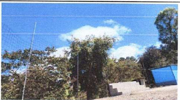
Foto 11: Imagen donde se observa el estado actual del muro perimetral existente.
