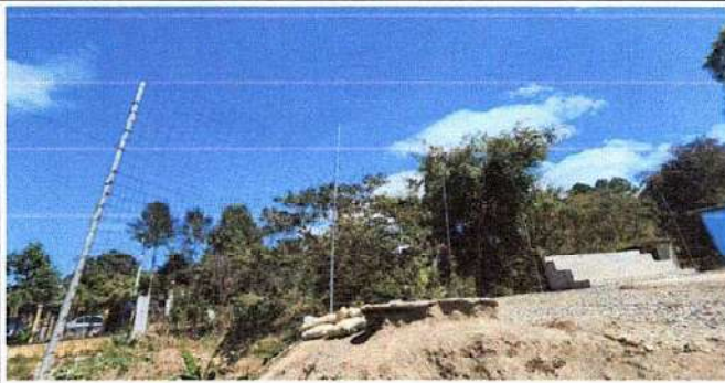
Foto 7: Imagen donde se observa el estado actual del ingreso del centro educativo.
