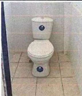
Foto 11: Imagen donde se observa el estado actual de los inodoros de los servicios sanitarios.
