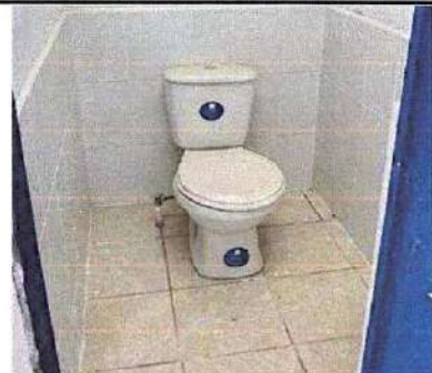
Foto 12: Imagen donde se observa el estado actual de los inodoros de los servicios sanitarios
