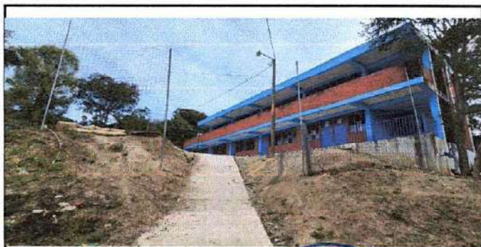
Foto 17: Imagen donde se observa el estado actual del área de ingreso al establecimiento.
