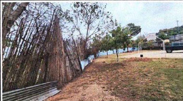
Foto 7: Imagen donde se observa el estado actual del muro perimetral existente
