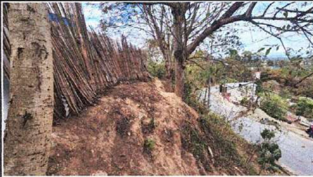
Foto 2: Imagen donde se observa el estado actual del muro perimetral existente
