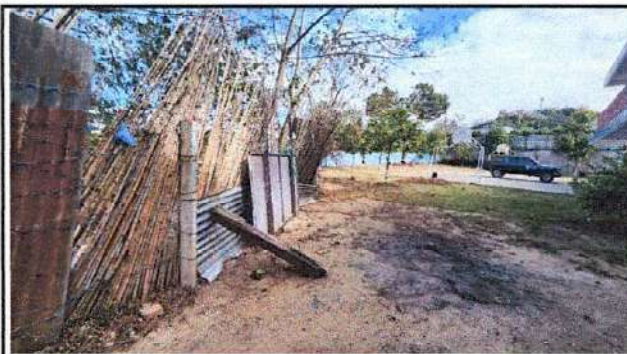
Foto 4: Imagen donde se observa el estado actual del muro perimetral existente
