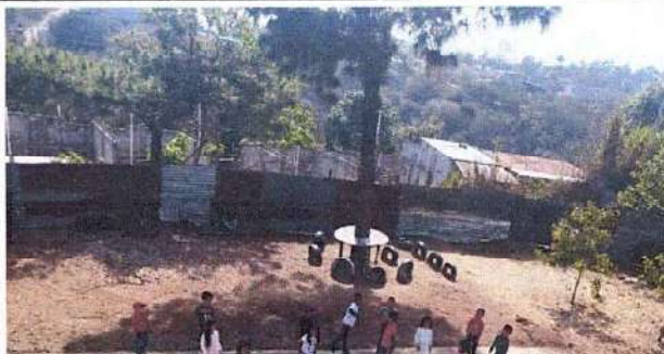
Foto 8: Imagen donde se observa el estado actual del muro perimetral existente
