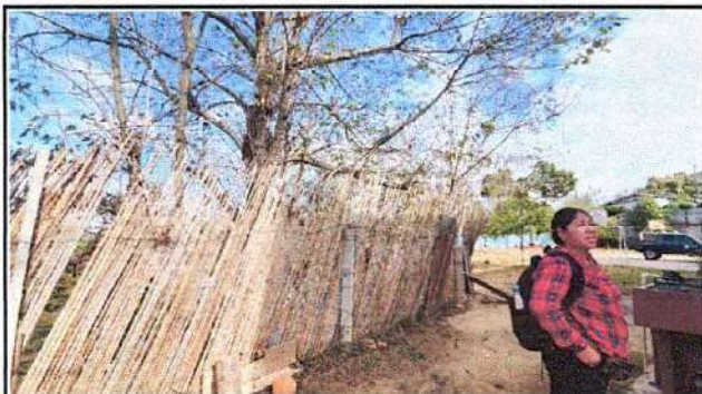
Foto 3: Imagen donde se observa el estado actual del muro perimetral existente
