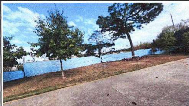
Foto 1: Imagen donde se observa el estado actual del muro perimetral existente
