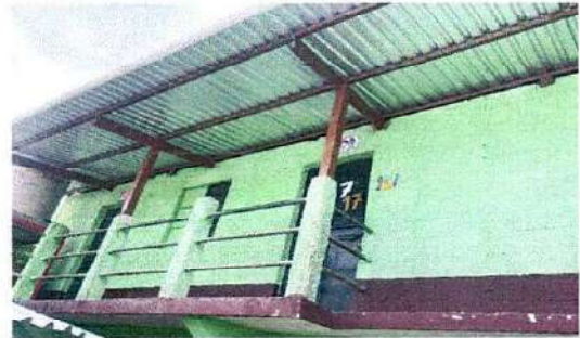
Foto 2: reparación de pared del segundo nivel, cernido y pintura interno y externo
