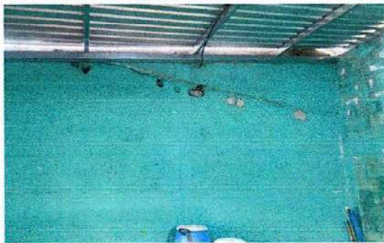
Foto 3: reparación inteno del aula, cernido y pintura
