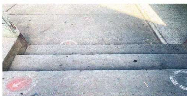
Foto 3: reparación de gradas y cernido
