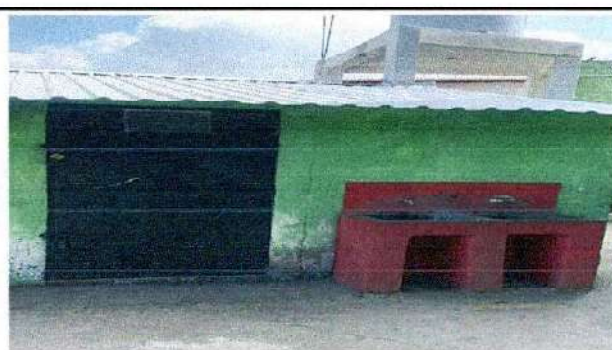
Foto 6: cernido de bodega interno y externa
