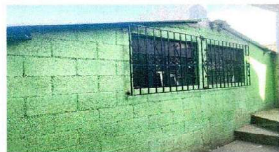
Foto 6: reparación de columnas a bodega y levantamiento de tres hiladas de block
