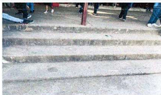
Foto 1: reparación de gradas y cernido
