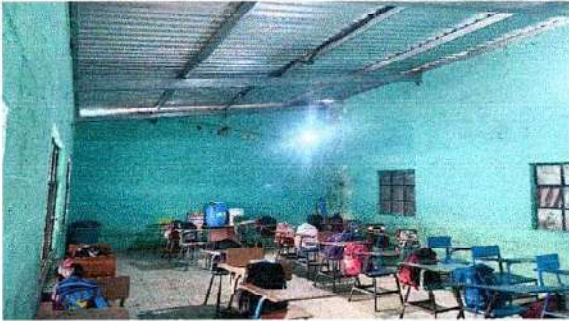
Foto1: reparación de pared, cernido y pintura
