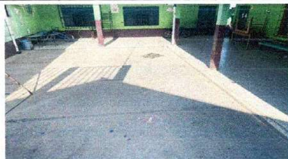
Foto 5: reparación de torta de cemento del patio y colacion de piso antideslizante
