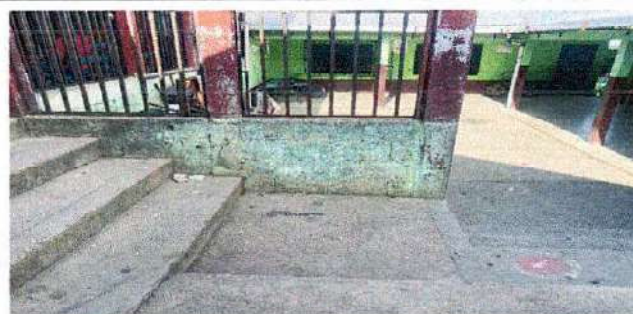
Foto 2: reparación de gradas y cernido
