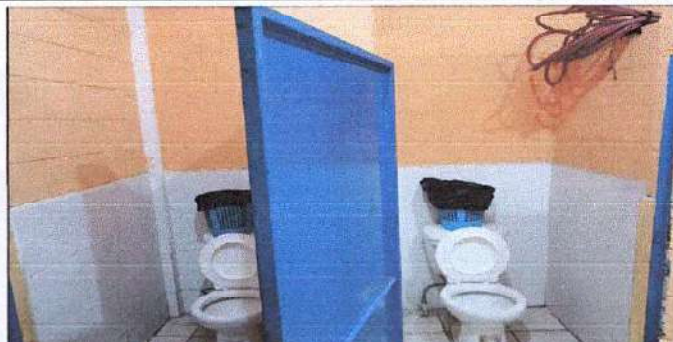
Foto 2: Sustitución de inodoros
