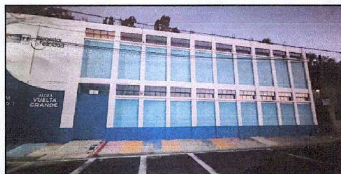
Foto 6: Pintura en exteriores
