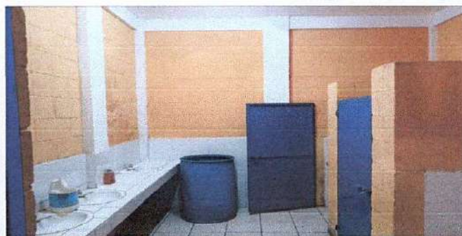
Foto 4: Sustitución de lavamanos
