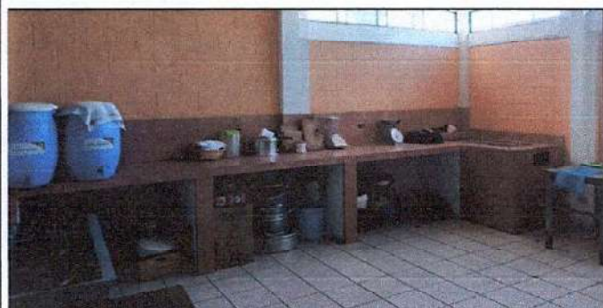
Foto 3: Reparación de azulejo en muebles de cocina
