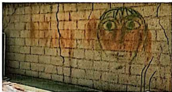
Foto 1: Reparación de muro de block en área de bodega
