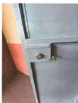
Foto 5: Sustitución de chapa en aula de módulo 1.
