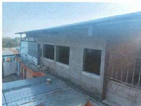
Foto 3: Sustitución de ventana-balcon de metal en módulo 2.
