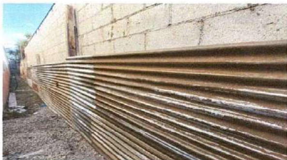
Foto 1: Reparación de muro perimetral de block con tubo hg y malla galvanizada, soleras intermedias y columnas en el lado sur del edificio escolar.
