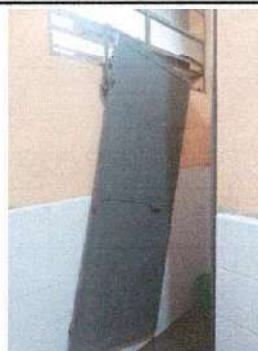
Foto 4: Sustitución de puerta en servicios sanitarios de niños módulo 2
