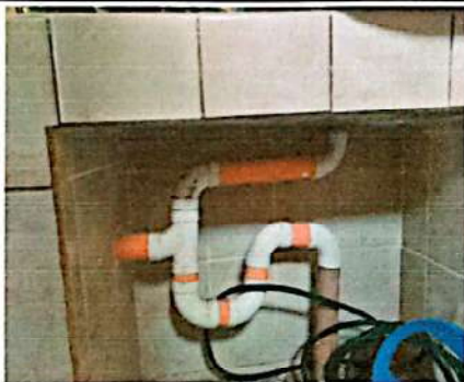
Foto 9: Reparación de tubería de drenaje de lavamanos de los sanitarios.
