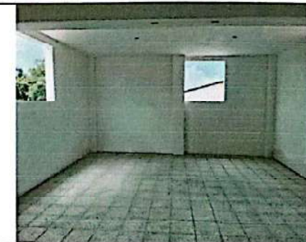
Foto 6: Instalación eléctrica en aula 1, 2, 3 y 4 del módulo 3.
