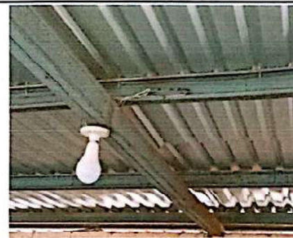
Foto 9: Mejoramiento de sistema eléctrico en aulas 1, 2, 3, 4, 5 y 6 del módulo 1, (30 plafoneras, 18 tomacorrientes, 12 interruptores incluye sustitución de cableado y unidades existentes por nuevas)
