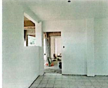
Foto 8: Sustrucción de accesorios de energía eléctrica en módulo 1, aulas 1, 2, 3, 4, 5 y 6, incluyendo el corredor.
