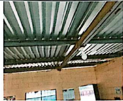
Foto 8: Mejoramiento de sistema eléctrico en aulas 1, 2, 3, 4, 5 y 6 del módulo 1, (30 plafoneras, 18 tomacorrientes, 12 interruptores incluye sustitución de cableado y unidades existentes por nuevas)
