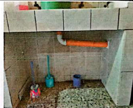
Foto 10: Reparación de tubería de drenaje de lavamanos de los sanitarios.
