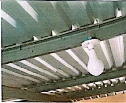
Foto 7: Mejoramiento de sistema eléctrico en aulas 1, 2, 3, 4, 5 y 6 del módulo 1, (30 plafoneras, 18 tomacorrientes, 12 interruptores incluye sustitución de cableado y unidades existentes por nuevas)
