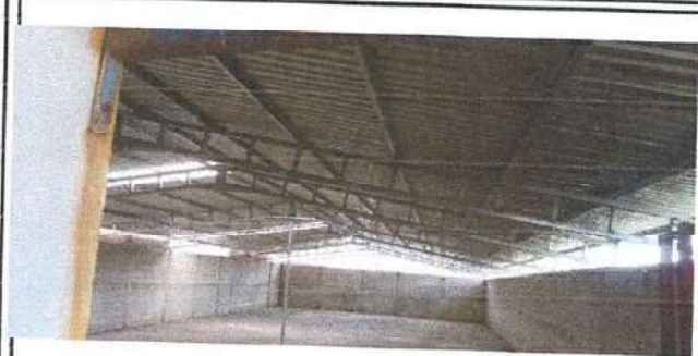
Foto1: CERNIDO Y LOSA DE PATIO
