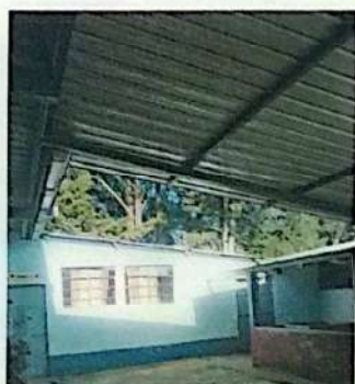
Foto 5: Gracias a que se cuenta con un techo de estructura de metal iniciada, la continuidad del techado se podrá continuar de forma efectiva.
