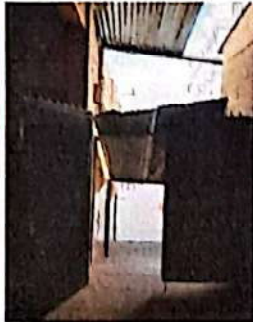
Foto 1: Módulo 1 sustitución de techo de dos caldas de la entrada principal debido a que el suelo del área presenta filtraciones de agua en el tiempo de invierno.
