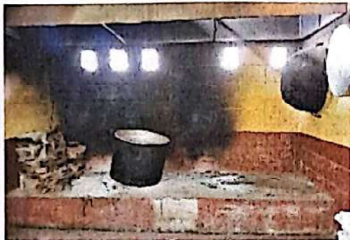
Foto 7: Módulo 2 sustitución de estufa rural por estufas industriales e instalación de tubería de gas para el área de cocina, para agilizar la preparación y cocción de alimentos. Así mismo para evitar la contaminación por el humo.
