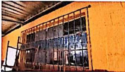
Foto 3: Módulo 2 sustitución de balcón de biblioteca debido a que se encuentran deteriorados.
