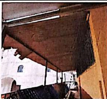
Foto 5: Módulo 2 sustitución de 20 m² de cubierta de lámina galvanizada por lámina troquelada de Aluzinc calibre 26, de una calda de agua de (fachada principal).
