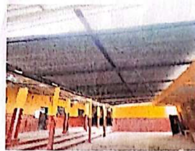
Foto 4: Módulo 2 sustitución de 76m2 cubierta de lámina galvanizada, de patio frente a salones 3, 4, 10 y 9 por lámina troquelada de Aluzinc calibre 26.
