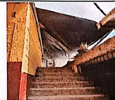
Foto 6: Módulo 4 sustitución de techo de nylon por techo lámina troquelada de dos caldas en el área de sanitarios del establecimiento.
