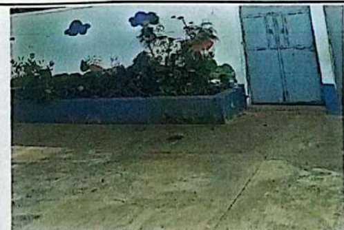
Foto 12: La pintura de los bordes de block que se ubican frente a cada módulo se encuentran en malas condiciones.
