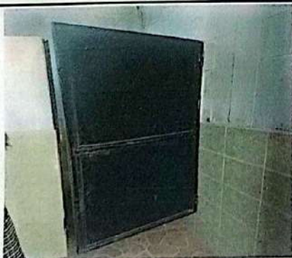
Foto 5: Las puertas metálicas de los sanitarios se encuentran en malas condiciones, presentan desgaste en el metal.
