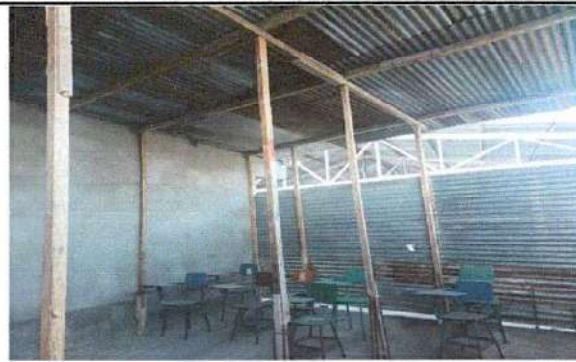
Foto 2: Sustrucción de estructura de soporte de madera, por metal en módulo 2
