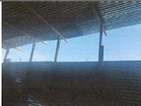
Foto 1: Sustrucción de lámina, por lámina troquelada aluzinc calibre 26 en módulo 2
