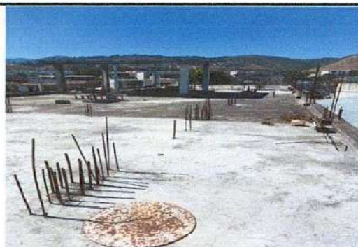
Foto 5: Impermeabilización de losa en módulo 1
