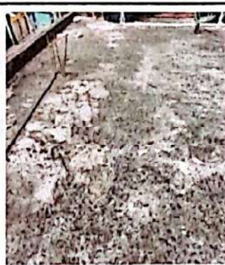
Salón 18. Mejoramiento de losa con impermeabilizante elastomérico de tipo acrílico estirado de tipo acrílico uso para losa y paredes.
