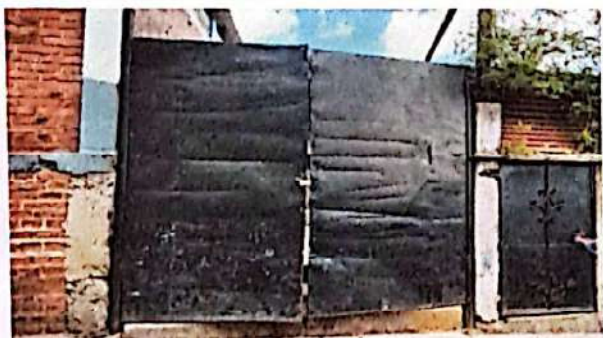
Salón 18. Sustitución de portón de lata por portón corredizo.
