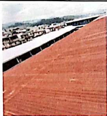
Cubierta de lámina. Sustitución de lámina galvanizada por lámina troquelada Calibre 28 Aluzinc
