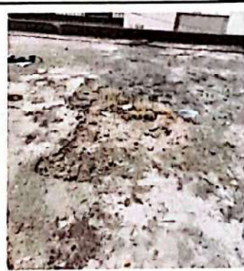
Salón 18. Mejoramiento de losa con impermeabilizante elastomérico de tipo acrílico estirado de tipo acrílico uso para losa y paredes.
