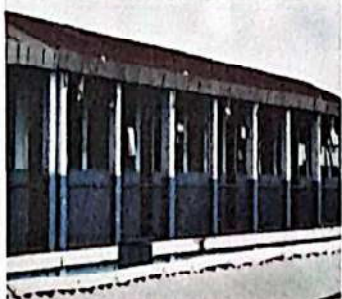
Cubierta de lámina. Sustitución de lámina galvanizada por lámina troquelada Calibre 28 Aluzinc
