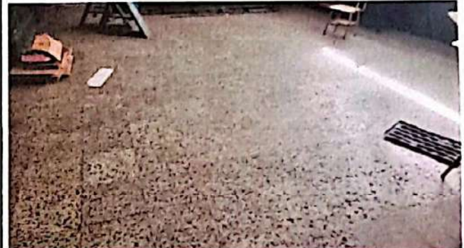
Salón 16. Piso. Sustitución de Piso de Granito Antiguo por Piso de Granito Nuevo y Estuque. Sacado de material (piso) viejo, ripio, tierra, otros.
