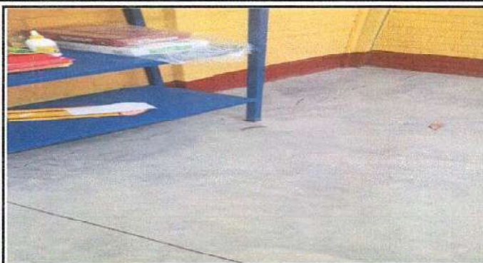
Foto 1: EL SALÓN TIENE UN HUNDIMIENTO A LO LARGO
