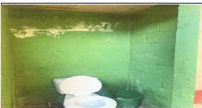
Foto 5: SE COLOCARÁ AZULEJO EN LAS PAREDES
