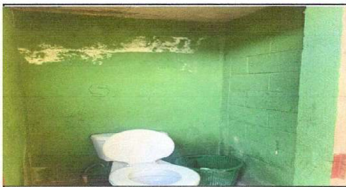
Foto 5: SE COLOCARÁ AZULEJO EN LAS PAREDES
