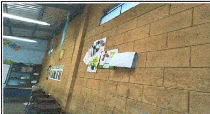
Foto 2: IMPORTANCIA MEJORAR AMBIENTE DE TRABAJO. APLICACIÓN DE PINTURA EN PAREDES.
