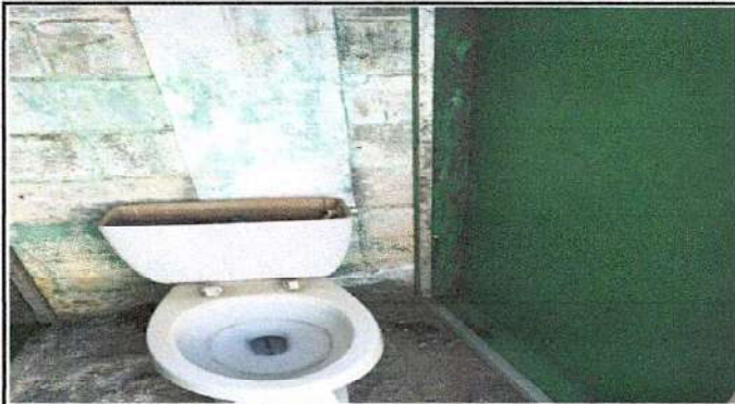
Foto1: Cambio de sanitario por deteriorado. (sur)
