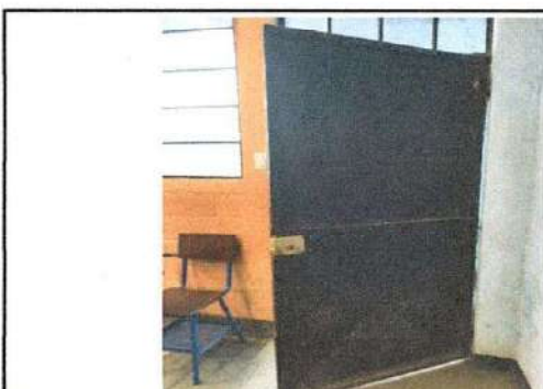
FOTO 5: PUERTA DE AULA SEGUNDO NIVEL CON NECESIDAD DE SUSTITUCION. Marco y pines de la misma quebrados.
