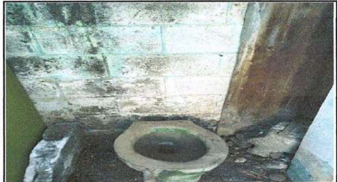
Foto 2: Cambio de sanitario por antigüedad (sur)
