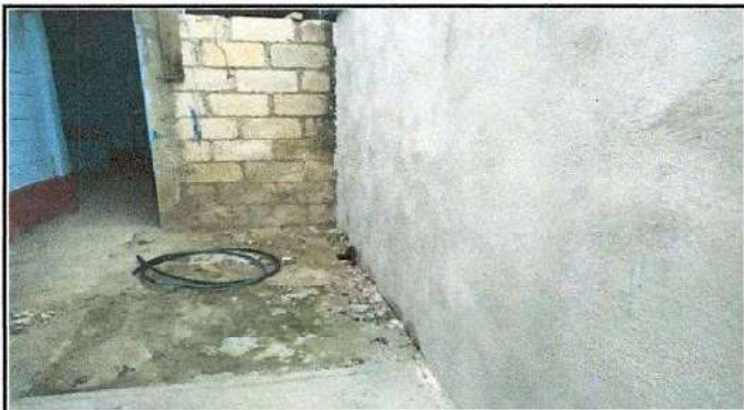
Foto 3: Espacio para instalación de dos sanitarios. (norte)
