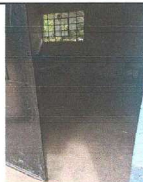
Foto 4: SERAN REMOZADAS LAS PUERTAS DE LAS AULAS A LAS CUALES LES PONDREMOS PISO
