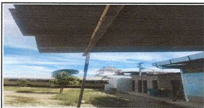
Foto 5: Mantenimiento de estructura de soporte
