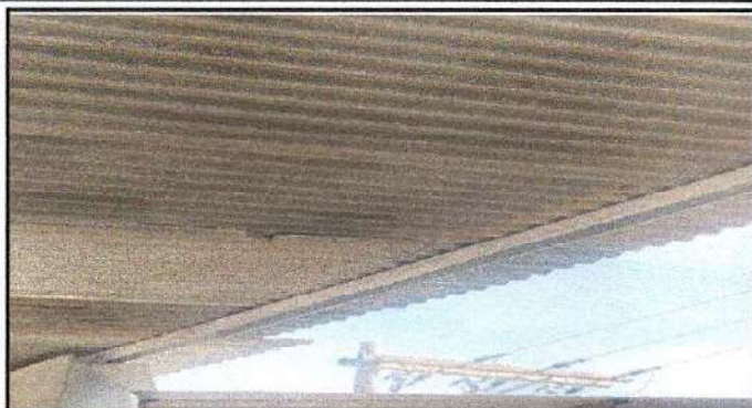
Foto 1: Mantenimiento y pintura a estructura de soporte
