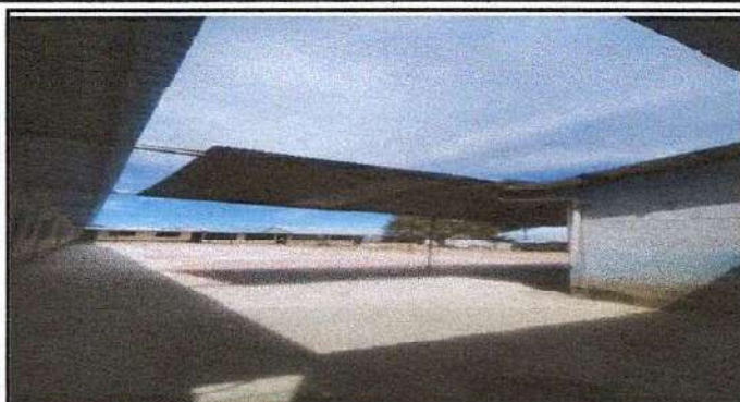
Foto 2: Instalación de lámina para el patio de la EORM Prados y Condado de San Juan
