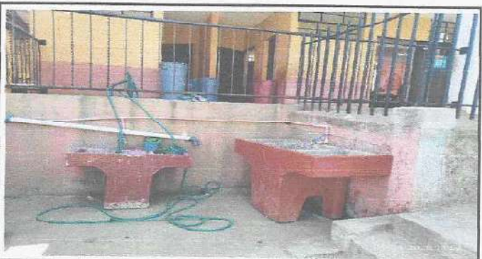
Foto 3: Se realizará reparación de muro en área de servicios sanitarios.
