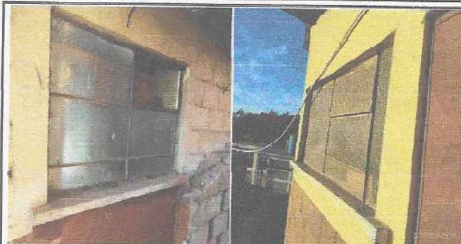
Foto 2: Imagen que muestra el área donde se realizará la instalación de ventanas, además, se instalará un piso anti-deslizante en el área de gradas para garantizar seguridad. También se realizará sustitución de pintura en muros.
