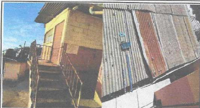
Foto 1: Imagen que muestra el área de bodega, donde se realizará sustitución de lámina y estructura metálica, así como la instalación de canales metálicos y bajadas de agua pluvial. También se realizará sustitución de piso y una puerta.
