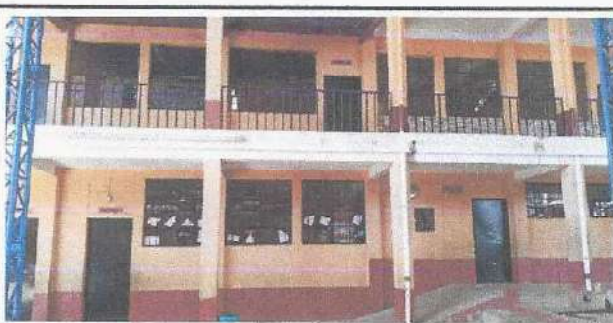
Foto 6: Suministro e instalación de balcones para ventanas
