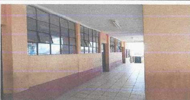
Foto 3: Reparación de estructura de metal de ventana
