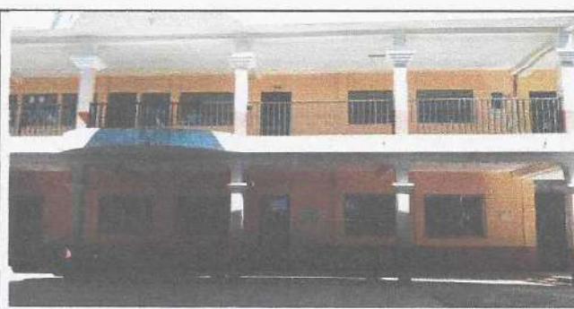
Foto 12: Sustitucion de pintura en muros exteriores de todas las aulas de la escuela.
