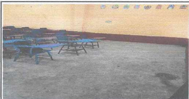
Foto 9: Sustitución de piso torta de concreto por piso ceramico, en cuatro salones de clases (incluye materiales y mano de obra).
