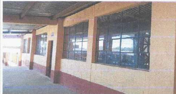
Foto 2: Reparación de estructura de metal de ventana
