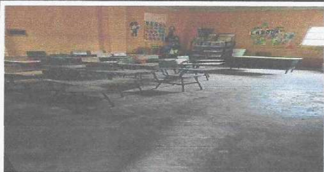
Foto 7: Sustitución de piso torta de concreto por piso ceramico, en cuatro salones de clases (incluye materiales y mano de obra).
