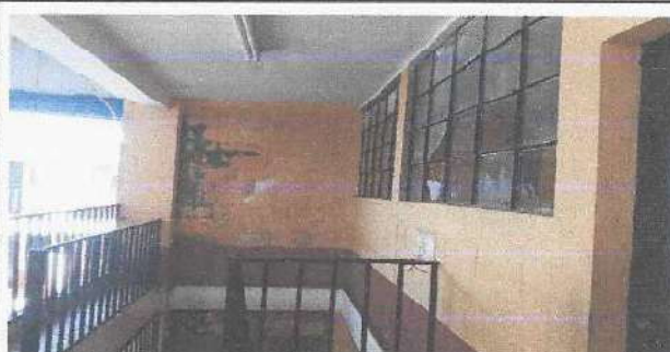
Foto 4: Reparación de estructura de metal de ventana
