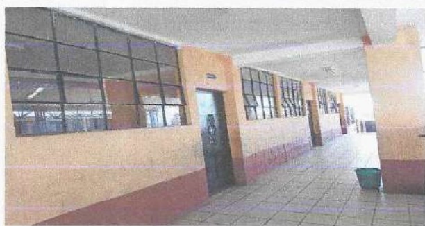
Foto 1: Reparación de estructura de metal de ventana
