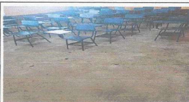
Foto 10: Sustitución de piso torta de concreto por piso ceramico, en cuatro salones de clases (incluye materiales y mano de obra).
