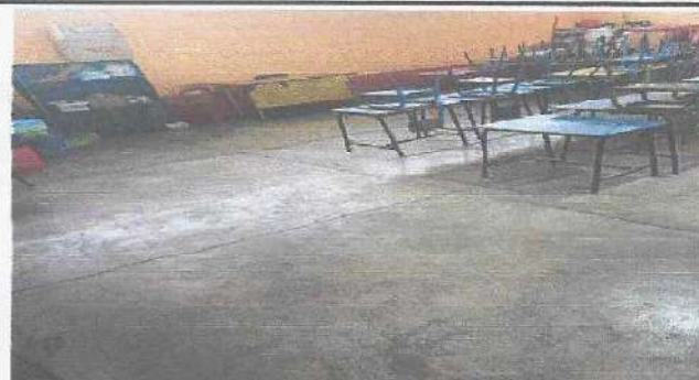
Foto 8: Sustitución de piso torta de concreto por piso ceramico, en cuatro salones de clases (incluye materiales y mano de obra).
