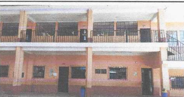
Foto 5: Suministro e instalación de balcones para ventanas
