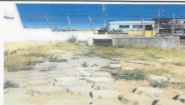
Foto 10: PISO DE TORTA DE CONCRETO Y ADOQUÍN AREA DEPOSITO DE BASURA. RENGLÓN 4. ARCHIVO ESCUELA.
