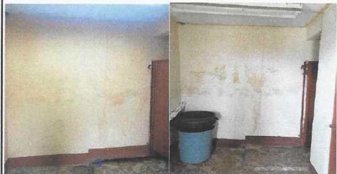
Foto 18: FILTRACIÓN DE AGUA DE LLUVIA EN MURO INTERIOR DE MÓDULO DE SANITARIOS. RENGLÓN 9. ARCHIVO ESCUELA.
