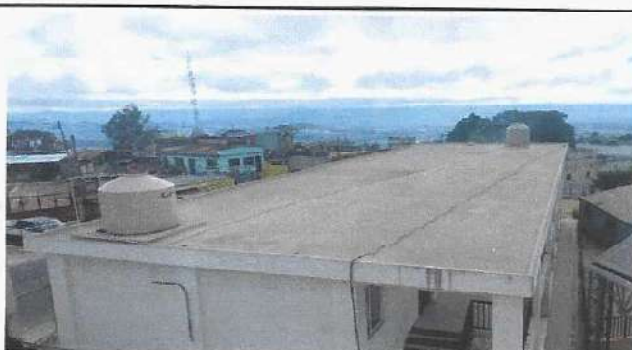
Foto 3: VISTA DE TERRAZA MÓDULO 3. 30X20M RENGLÓN 1. ARCHIVO ESCUELA
