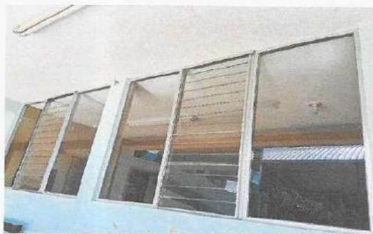
Foto 3: Debido al deterioro que presentan las ventanas de los salones que se encuentran en el primer nivel, se procederá a realizar la sustitución de los marcos de metal.
