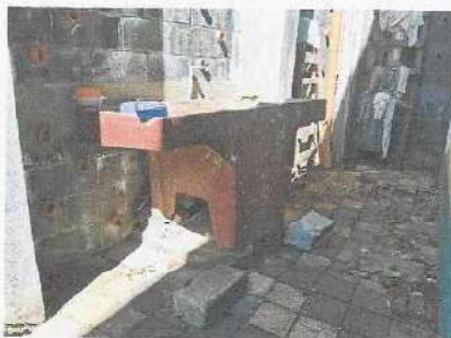
Foto 11: Debido al deterioro que presentan la pila, se procederá a sustituir la que se encuentra y a instalar una nueva pila de cemento.
