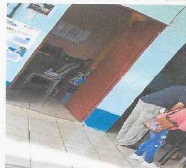
Foto 10: Se procederá a instalar una puerta de rejas en el área de Dirección para dar mayor seguridad del área.
