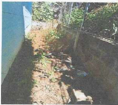
Foto 9: Debido a que el patio del área lateral norte del establecimiento presenta un deterioro, se procederá a mejorar el área.
