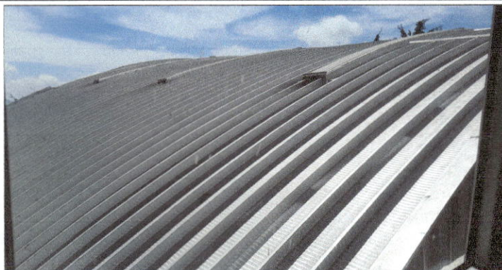
Foto 1: Mantenimiento a estructura de soporte de metal, sustitución de arcos iluminados.
