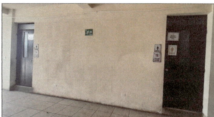
Foto 6: Mantenimiento a estructura a puertas servicios sanitarios hombres y mujeres primer nivel.
