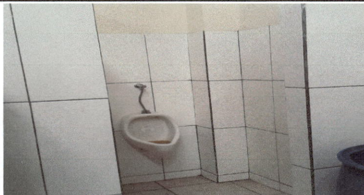
Foto 7: Sustrucción de mingitorio por inodoro y colocación de puerta de metal, baños de hombres auditorio.
