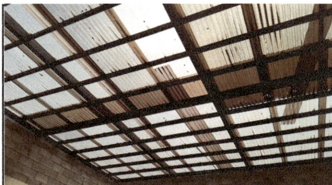
Foto 4: Sustitución de lámina troquelada y transparente.
