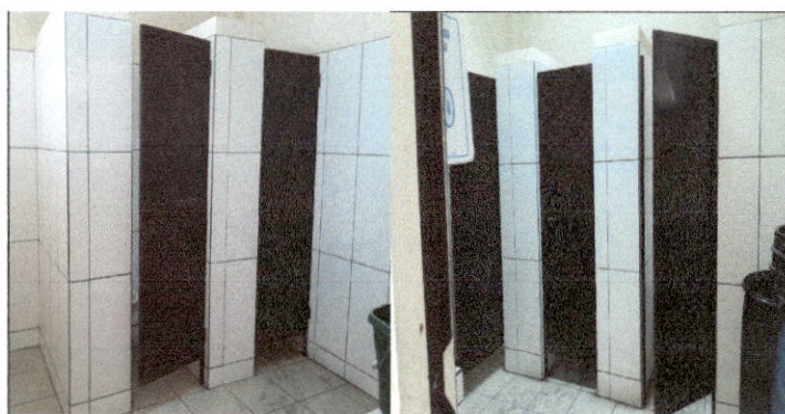
Foto 5: Mantenimiento a estructura a puertas servicios sanitarios hombres y mujeres primer nivel.
