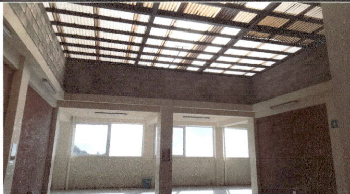
Foto 8: Repello en muro pergola sótano 1.
