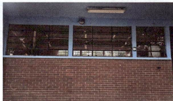
No. 2 Sustitución de estructura de metal por ventanas corredizas de aluminio en los salones del primer nivel y 1 salón del segundo nivel
