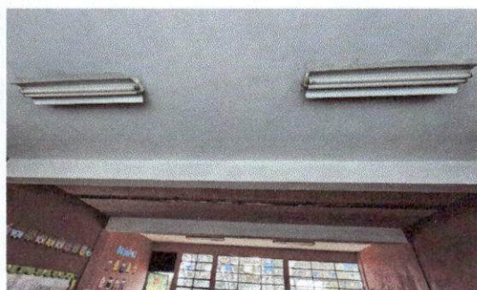
No.3 Reparación de sistema eléctrico en todos los salones
