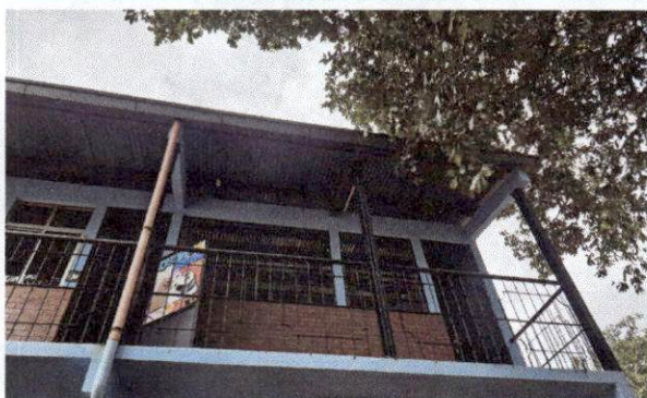
No.1 Cambio de canal y bajadas de agua pluvial
