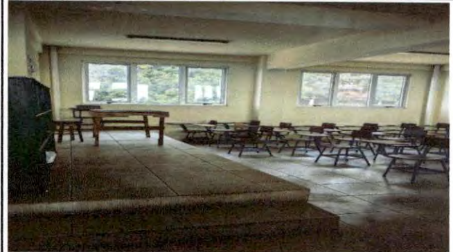
Foto 4: Aplicación de pintura en muros de interior de salones de clases del tercer nivel
