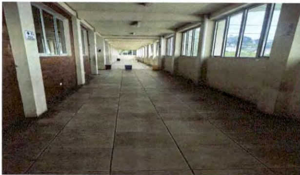
Foto 3: Aplicación de pintura en muros exteriores de corredores del tercer nivel
