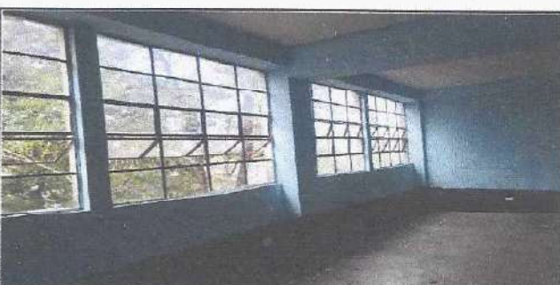
Foto 6: Ventanas con vidrios faltantes por oxidación en estructura
