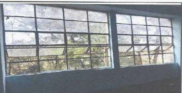
Foto 5: Ventanas de los salones, estructura completamente oxidada por lo que no pueden cerrarse
