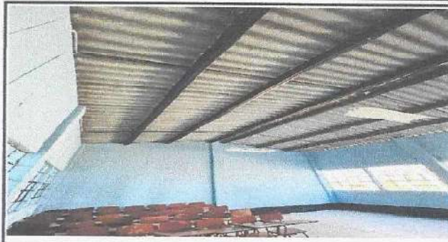
Foto 2: Lámina de duralita en salones de clase del segundo nivel ya con goteras.
