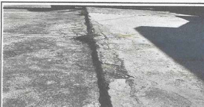
Foto 4: Sustitución de piso de torta de concreto (frente a 4 salones de clases)
