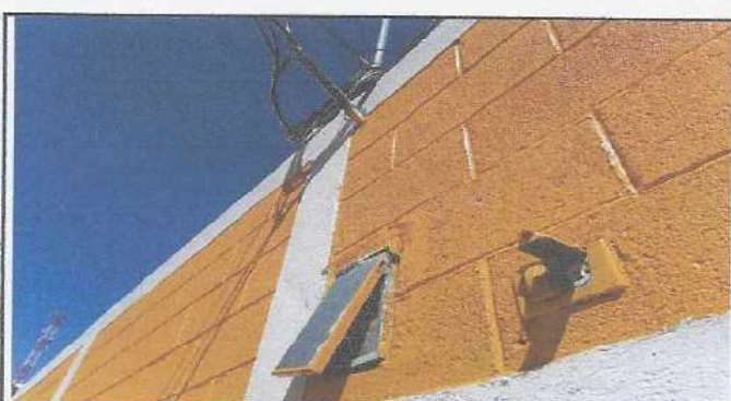
Foto 10: Mantenimiento de red eléctrica
