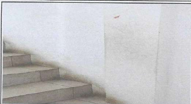
Foto7: Pintura interior y exterior de aulas
