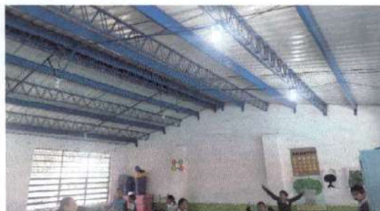
Foto 2: Sustitución de sistema eléctrico modulo 1. + plafoneras, por lamparas led de doble candela en planta alta
