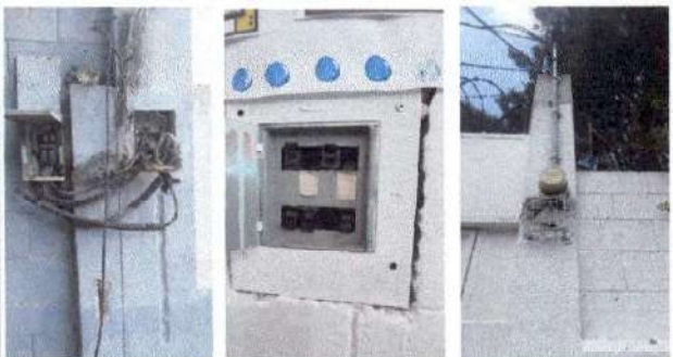
Foto 3: Sustitución de caja socket + tableros + cableado
