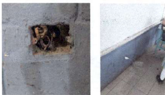
Foto 4: Reparación de sistema eléctrico en modulo 1 y 2. tomacorrientes en mal estado.
