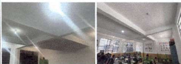
Foto 6: Sustitución de sistema eléctrico en modulo 1 y 2. Cambio de plafoneras y focos por lamparas led de doble candela
