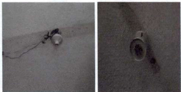
Foto 1: Sustitución de sistema eléctrico modulo 1. Cambio de plafonera en baños, + cableado por lamparas led de doble candela.
