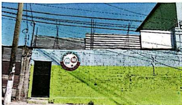
Foto 9: Sustitución de pintura en muros interior y exterior de todo el establecimiento.
