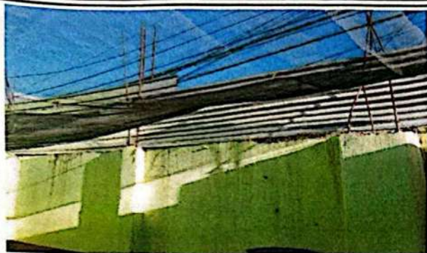
Foto 1: Reparación de muro perimetral (Frente y costado)
