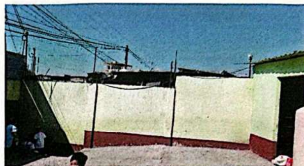
Foto 2: Reparación de muro perimetral (Frente y costado)
