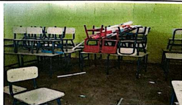
Foto 6: Sustitución de piso cerámico en tres aulas de preparatoria del segundo nivel.
