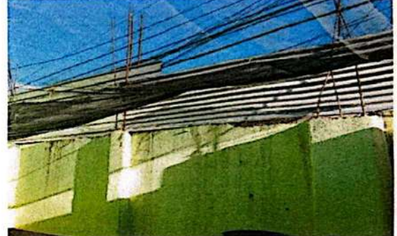
Foto 10: Sustitución de pintura en muros interior y exterior de todo el establecimiento.
