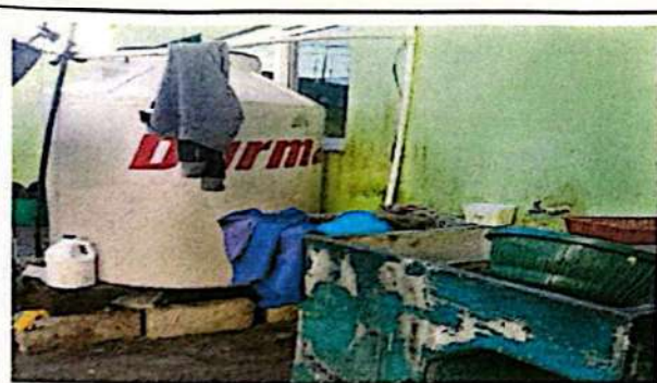
Foto 3: Suministros e instalación de torre metálica para tinaco de agua.
