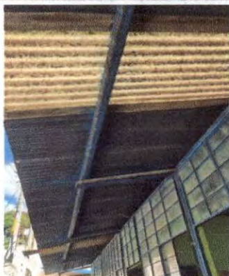
Foto 3: Mantenimiento a estructura.
