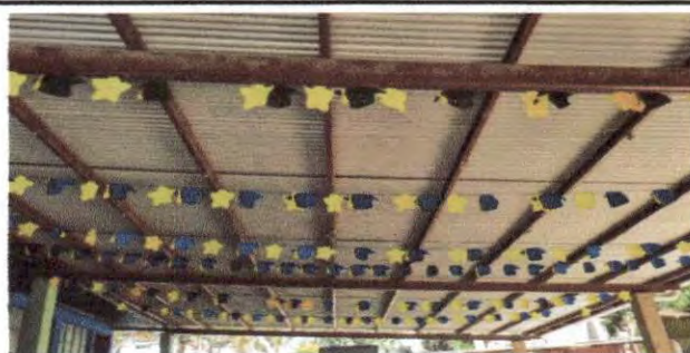
Foto 2: Mantenimiento a estructura a soporte de metal.
