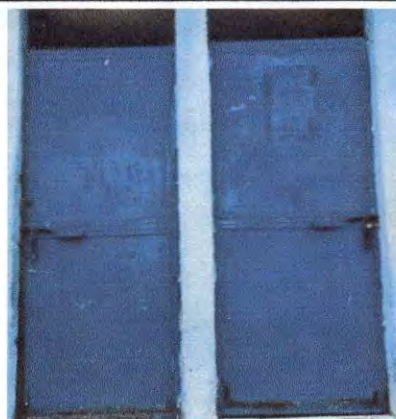
Foto 4: Pintura a puerta servicio sanitario.
