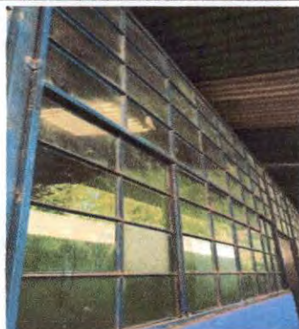
Foto 9: Mantenimiento a estructura de metal ventanas.
