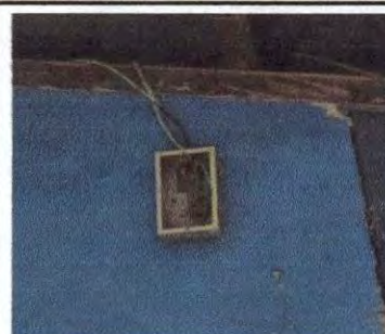
Foto 14: Reparación de sistema eléctrico.
