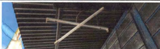
Foto 11: Sustrucción de lampara led.
