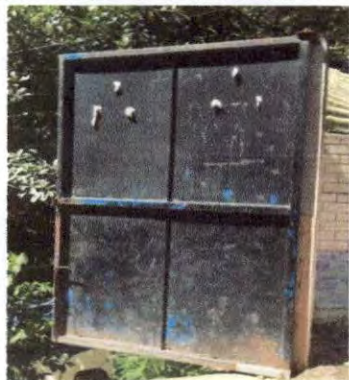
Foto 5: Mantenimiento a portones de metal
