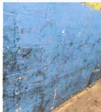
Foto 10: Pintura en muros exteriores e interiores
