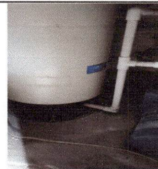
Foto 6: Reparación y mantenimiento de cisterna/ depósitos de agua
