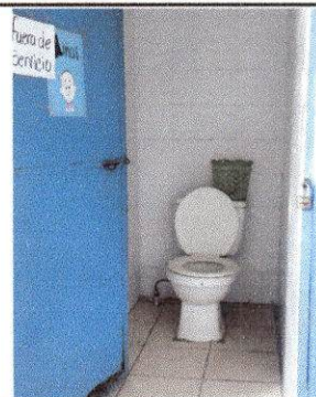
Foto 2: Reparación Servicios sanitarios y sus accesorios
