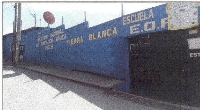
Foto 4: Cuneta - banqueta de concreto
