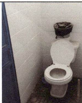
Foto 3: Reparación Servicios sanitarios y sus accesorios
